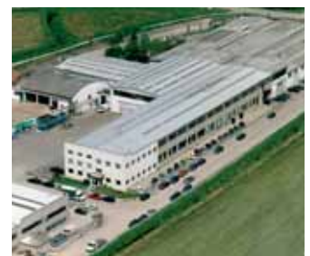
Vista aerea della nuova sede di Vernate - Milano.
